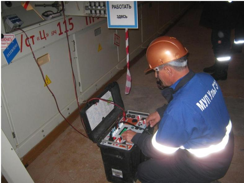
Проверка автоматических выключателей и устройств защитного отключения проводится перед вводом в эксплуатацию, после ремонта, а также в процессе эксплуатации.
